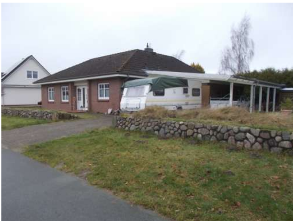
Straßenansicht von Osten
