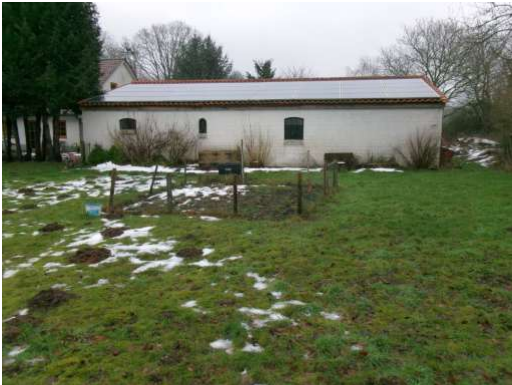
Ansicht Nebengebäude von Westen
