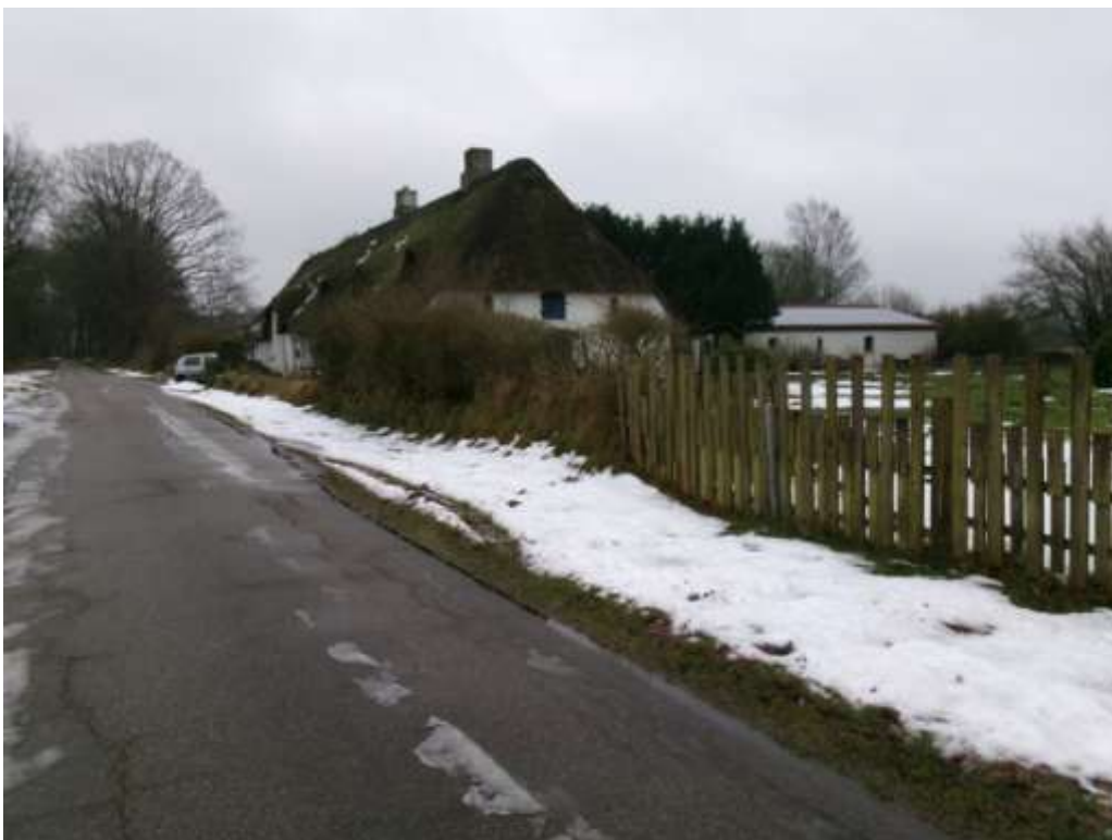
Straßenansicht von Nord-Westen
