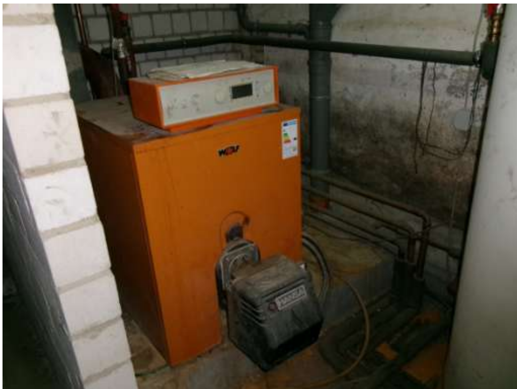
Nicht ausgebauter Bereich: Heizungsraum
