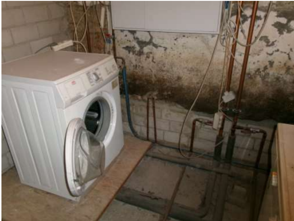
Nicht ausgebauter Bereich: Waschküche
