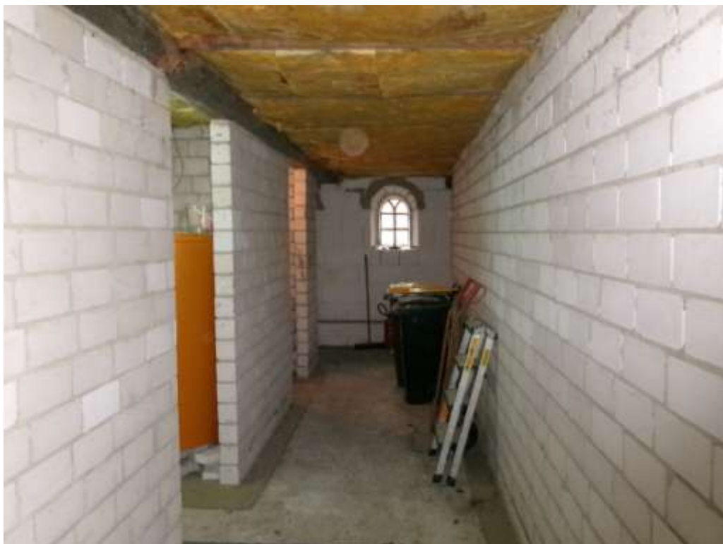
Nicht ausgebauter Bereich: Flur
