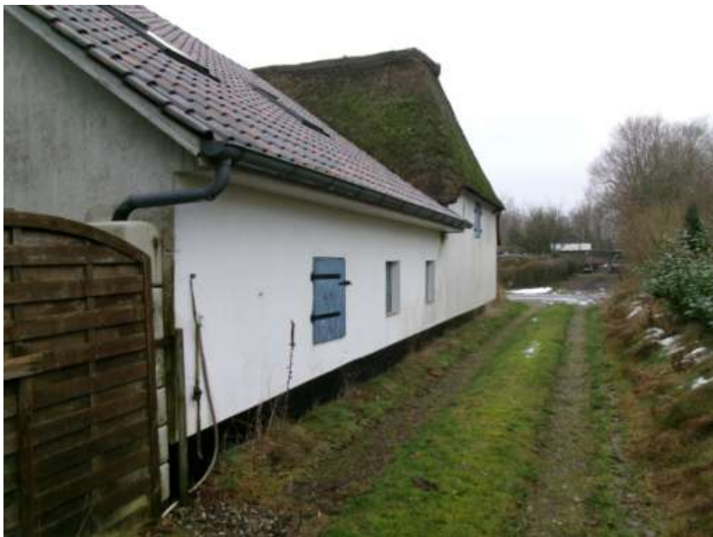
Östliche Fassade mit Zufahrt zum Carport
