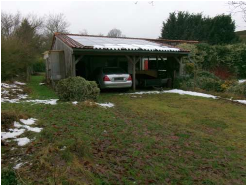
Ansicht Carport am Nebengebäude von Osten
