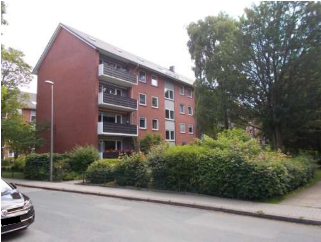
Straßenansicht von Nord-Westen
