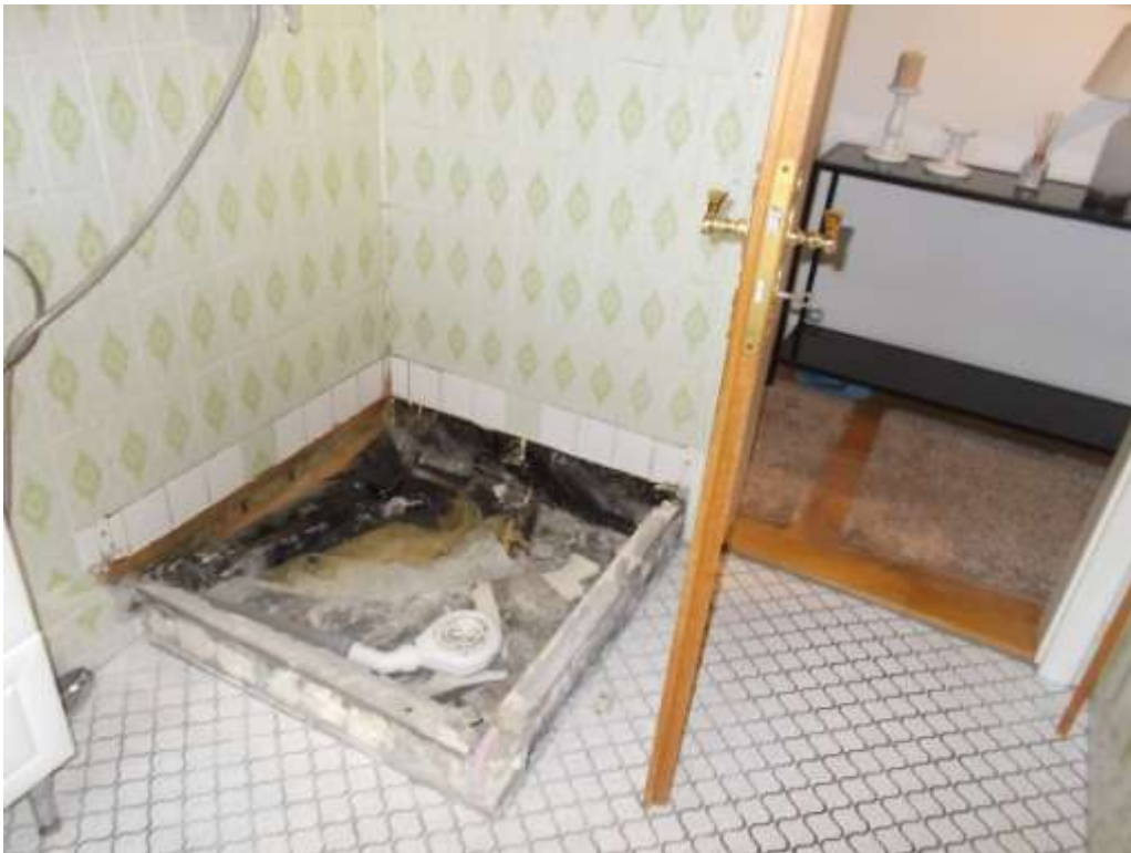
DG: Bad mit ausgebauter Duschtasse
