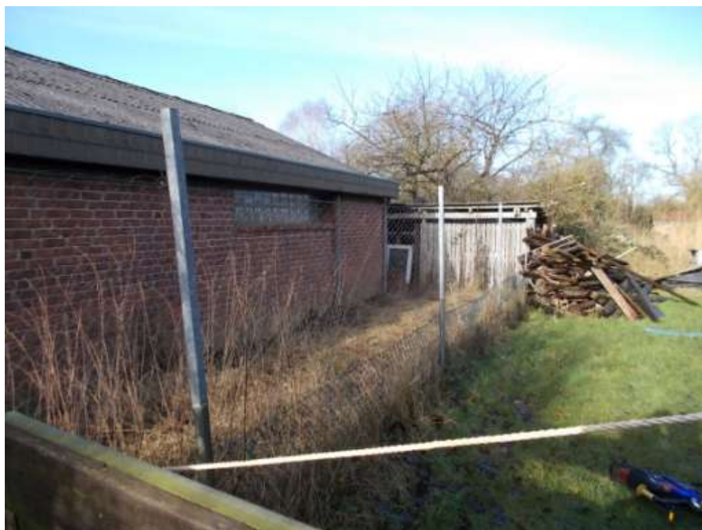
Östliche Fassade des Werkstattgebäudes
