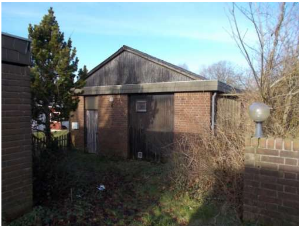
Giebelansicht Werkstattgebäude von Süden
