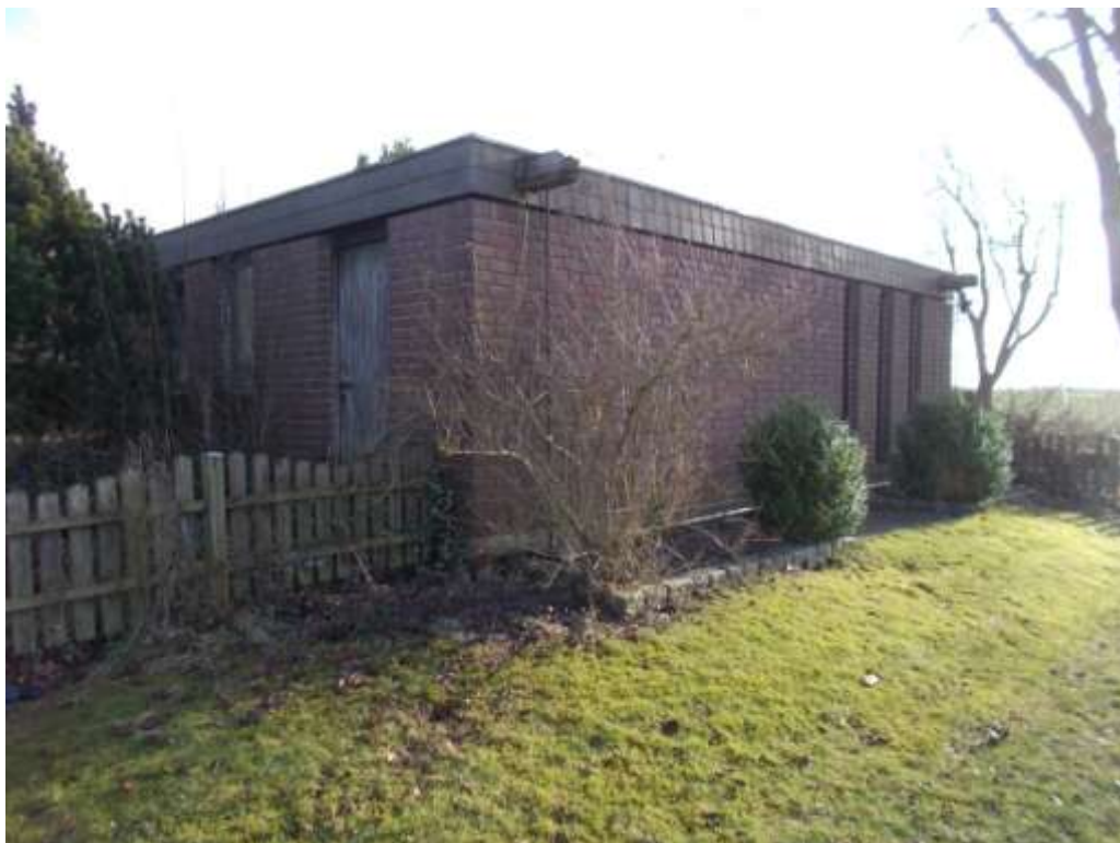
Ansicht Garagengebäude von Nord-Westen
