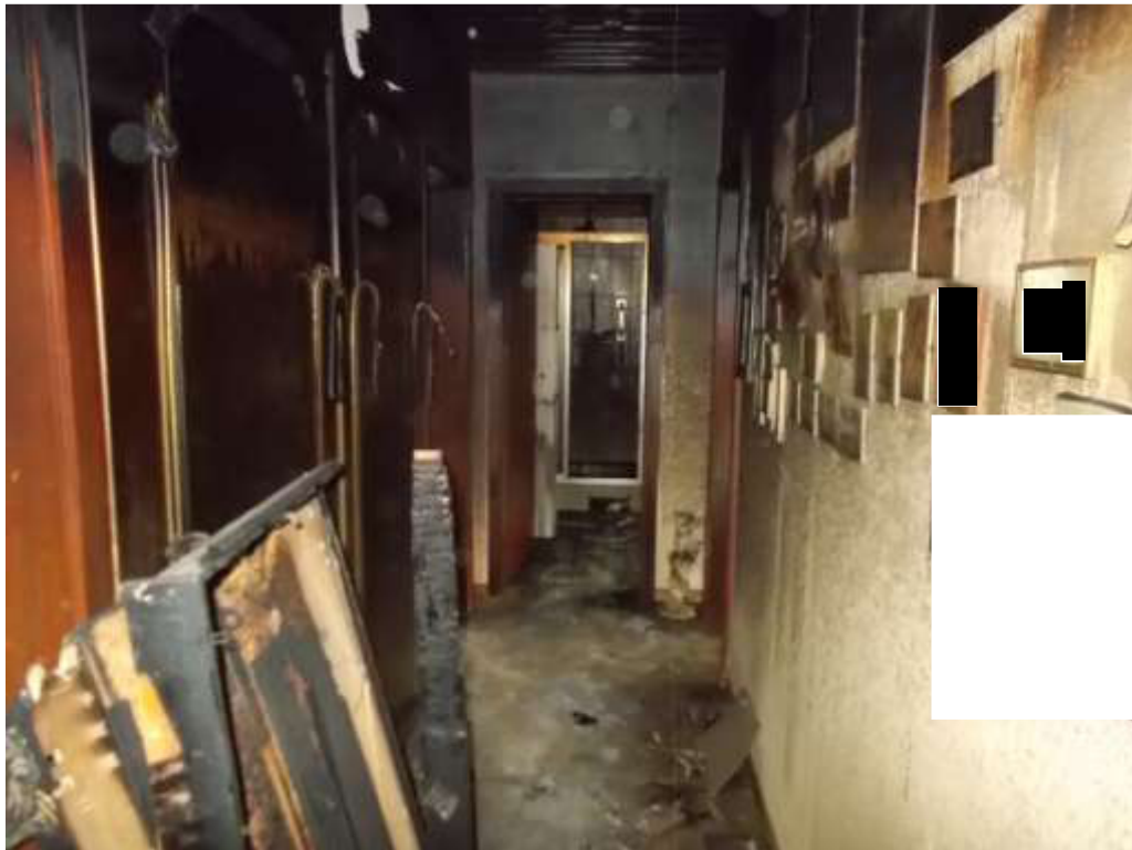
DG: Flur mit Blick Richtung Bad
