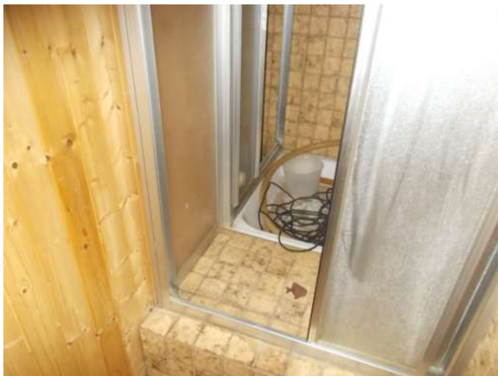
KG: Kellerraum mit Sauna und Dusche
