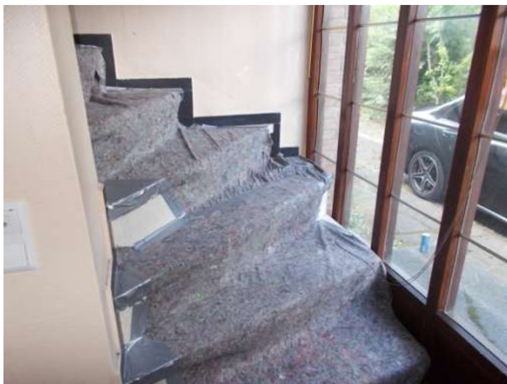
EG: Treppenflur im Eingangsbereich
