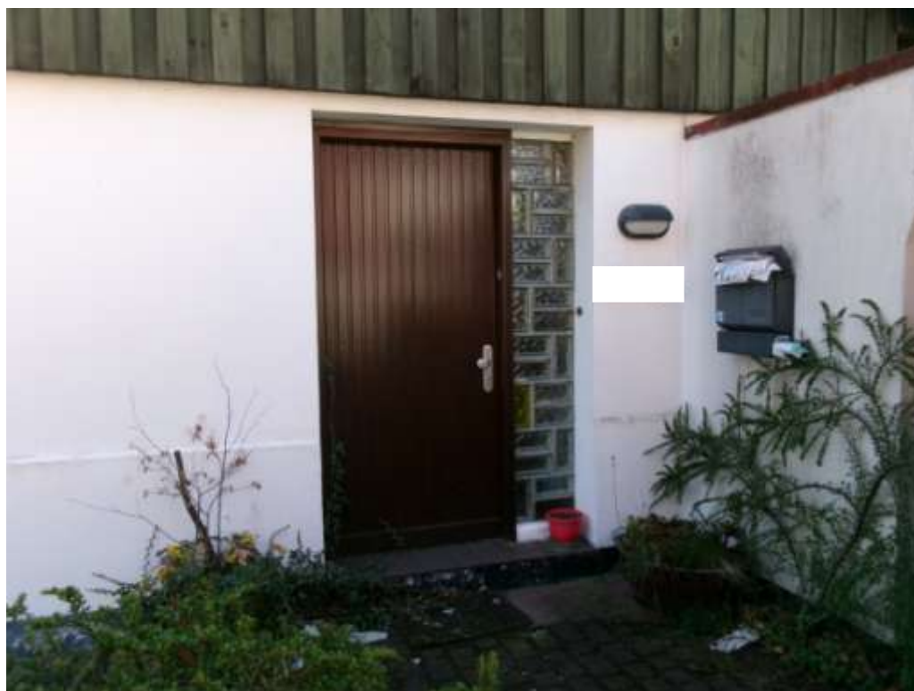
Eingangstür an der nördlichen Fassade
