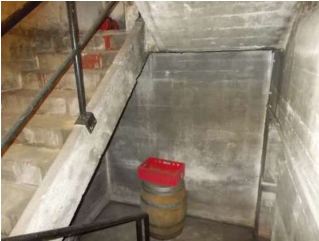
Lager- und Bürogebäude: Treppe ins Kellergeschoss
