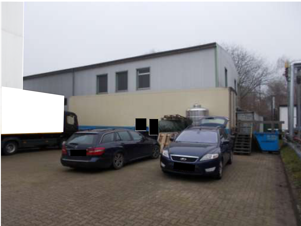
Ansicht Hallengebäude von Nord-Osten
