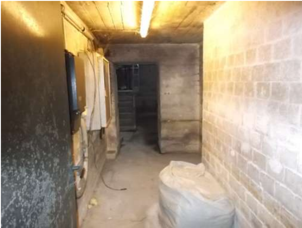
KG: Kellerraum mit Blick zum straßenseitigen Treppenhaus
