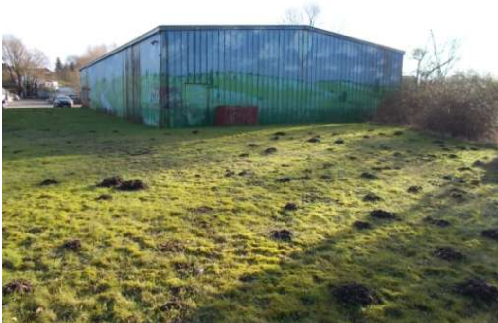
Ansicht Hallengebäude von Norden
