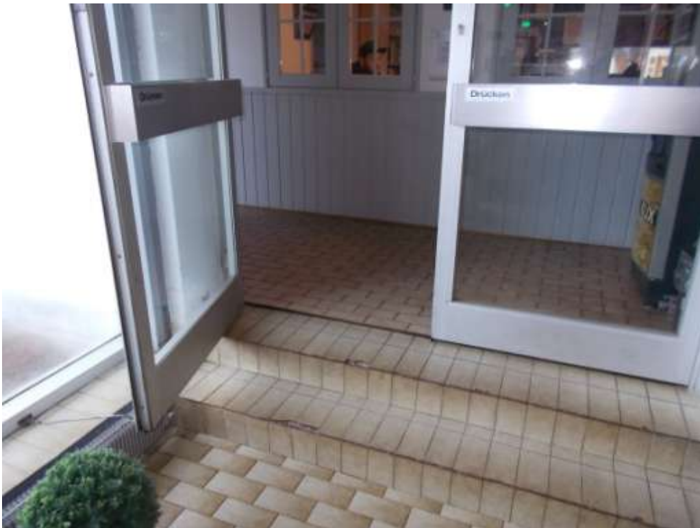
Ausstellungshalle: Übergang zum ursprünglichen Gebäude
