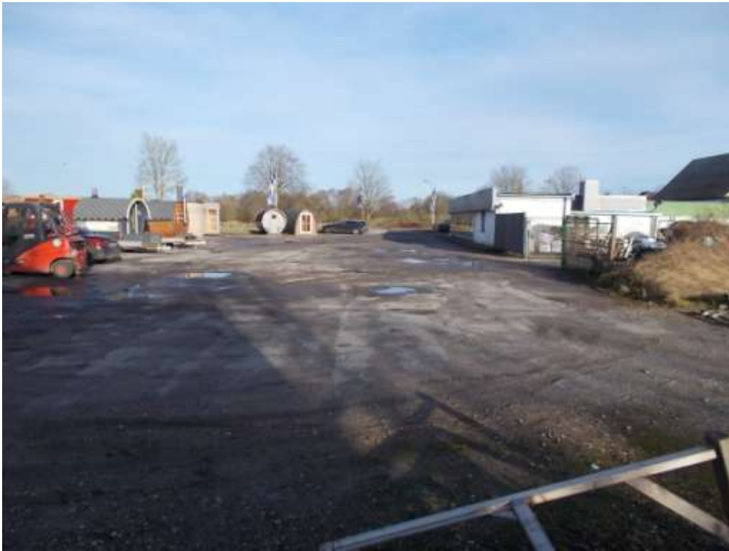
Zufahrtbereich – Fläche zwischen den beiden Hallengebäuden
