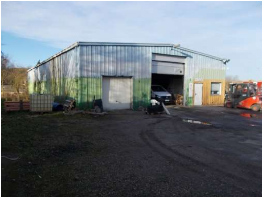
Ansicht Hallengebäude von Süden
