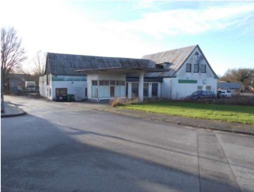
Ansicht Ausstellungs- und Werkstattgebäude von Nord-Osten
