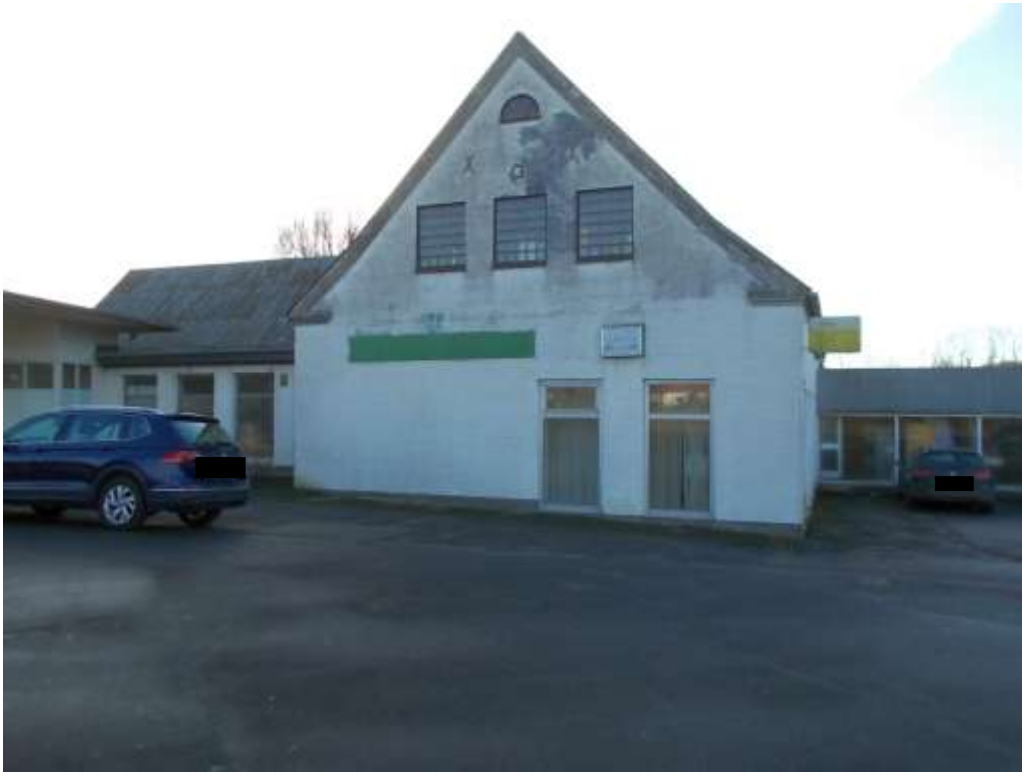
Ansicht von Nord-Osten (ursprünglicher Baukörper)
