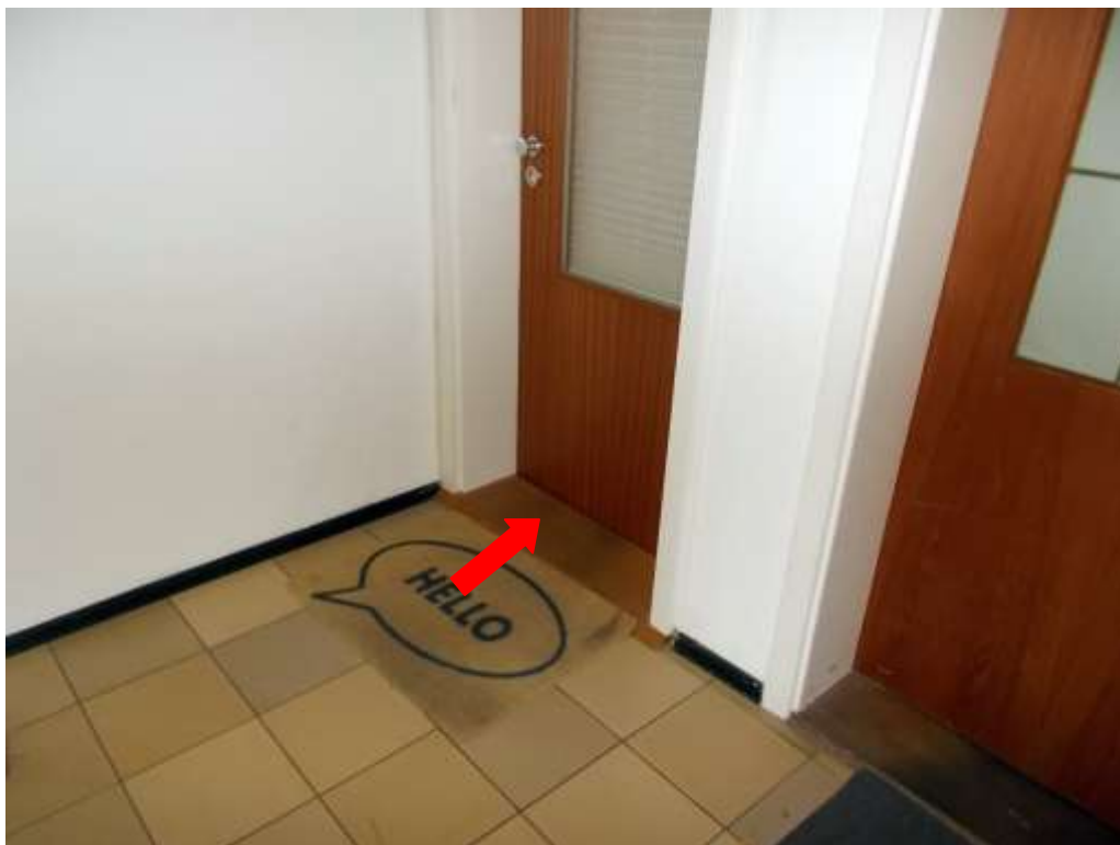
EG: Windfang mit Eingangstüren zu den Einheiten
