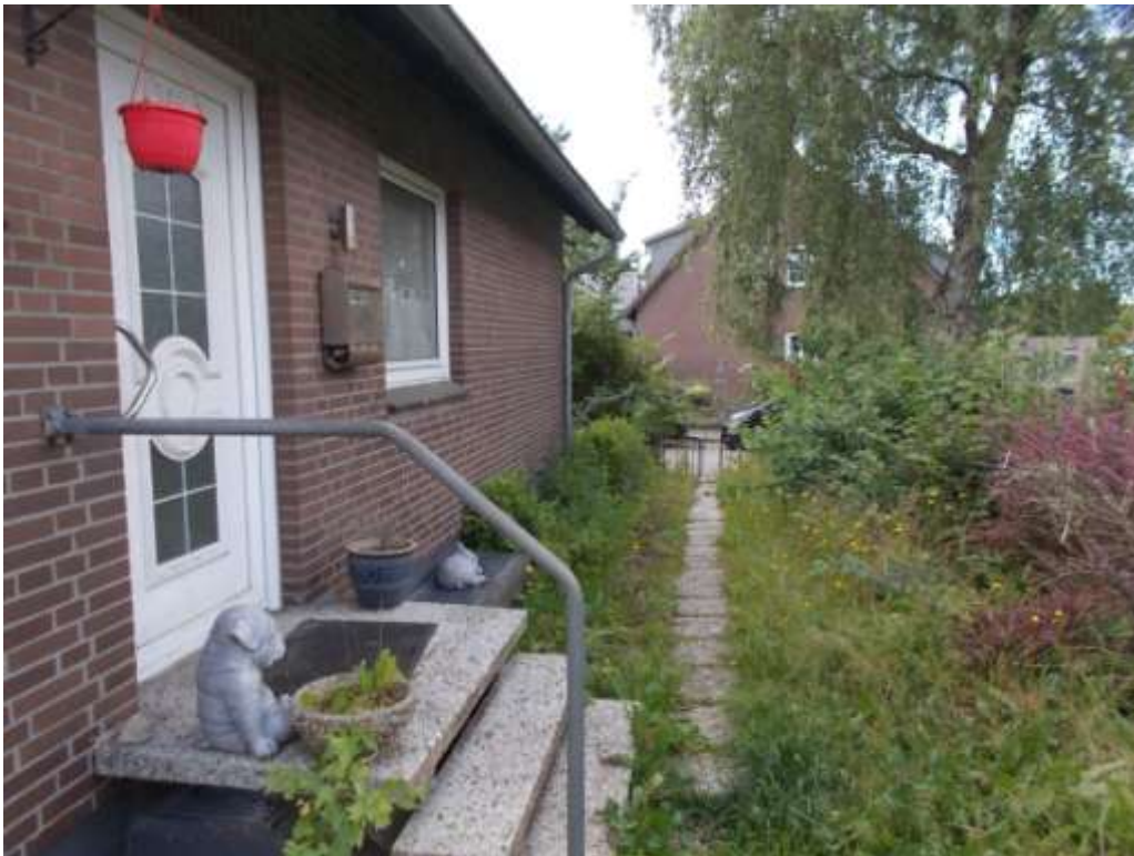
Nördliche Fassade mit Zugangssituation von der Straße
