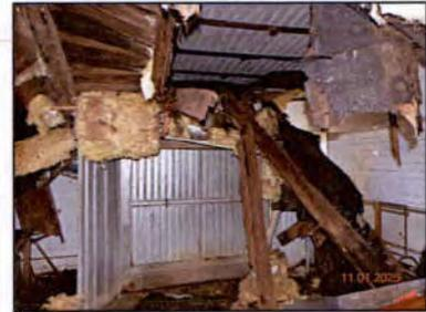
Wasserschäden an der Hallendecke und an Holzteilen
