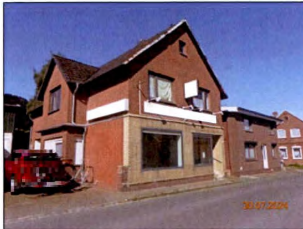
Straßenansicht von Osten
