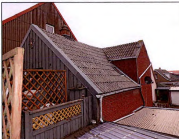
Dachgeschoss von Nordwesten
