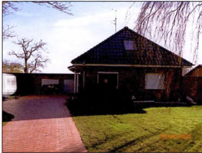
Straßenansicht von Südwesten
