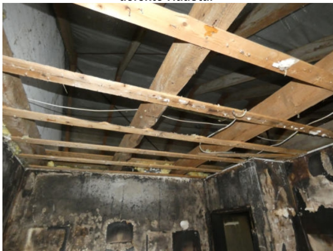
zerstörte Deckenverkleidung
