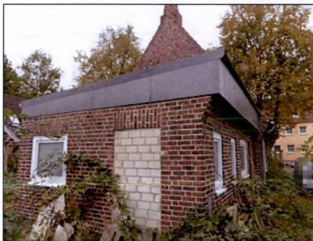
Anbau von Südosten
