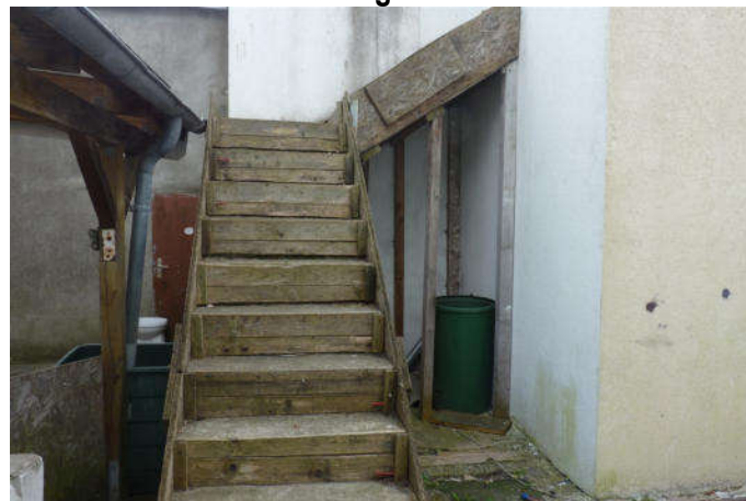
rückwärtige Treppe zur DG-Wohnung
