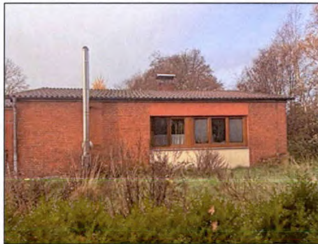
Ansicht von Osten
