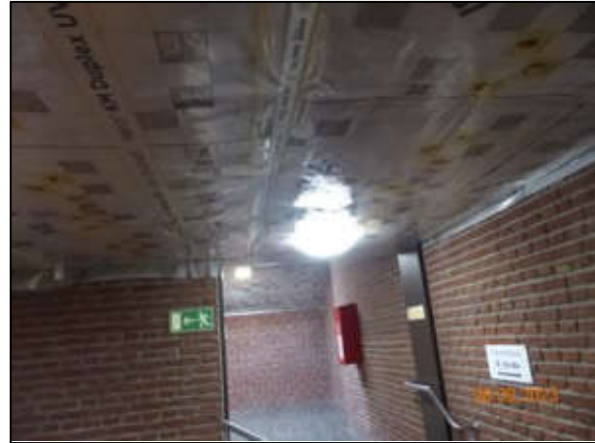
Fehlende Deckenverkleidung
