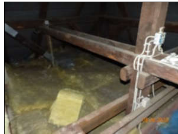
Fehlende Deckenverkleidung
