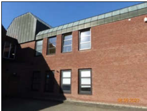
Ostfassade Koogstraße 41 rückwärtig
