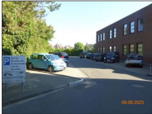
Koogstraße 41 rückwärtiges Gebäude Westfassade
