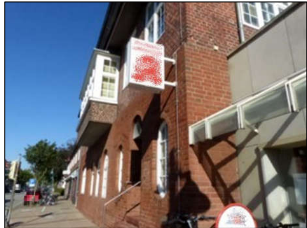
Südliche Fassade Koogstraße 43
