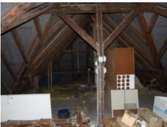
Dachboden Haus Nr. 41
