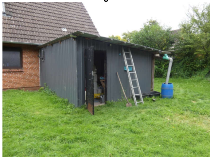
Öllagerschuppen hinter dem Haus
