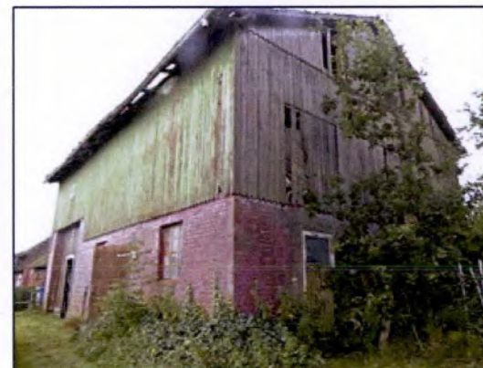
Wirtschaftsanbau von Nordwesten
