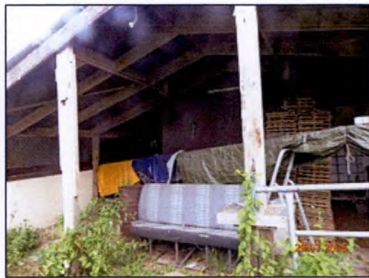
Blick in den Schuppen von Süden
