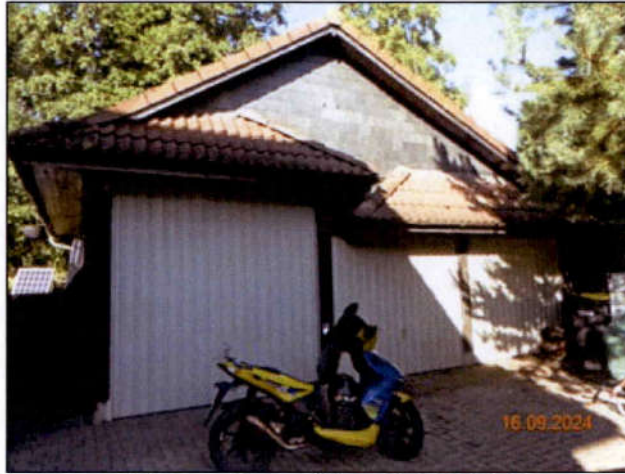
Garagenansicht von Osten (Flurstück 20/2) Hauptstr. 17
