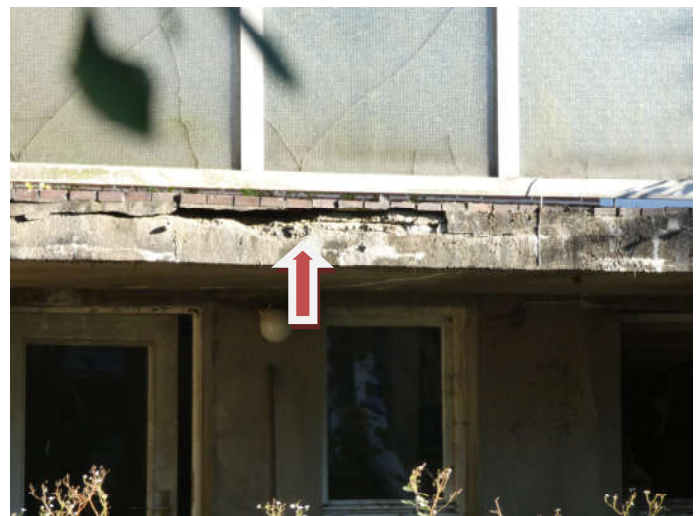
Schäden an der Terrassenkonstruktion
