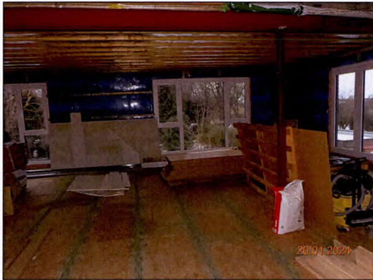
Raum im OG
