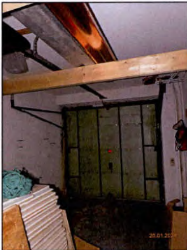
Blick in die Garage
