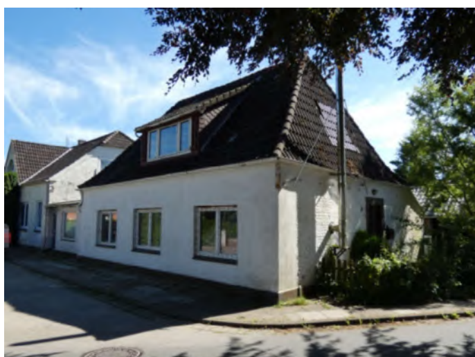
Straßenansicht II Ecke Rosenstraße/ Nordbahnhofstr.
