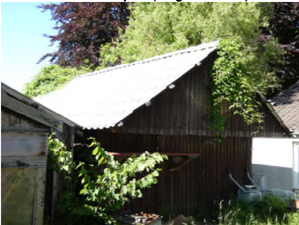
Carport, rückwärtige Ansicht
