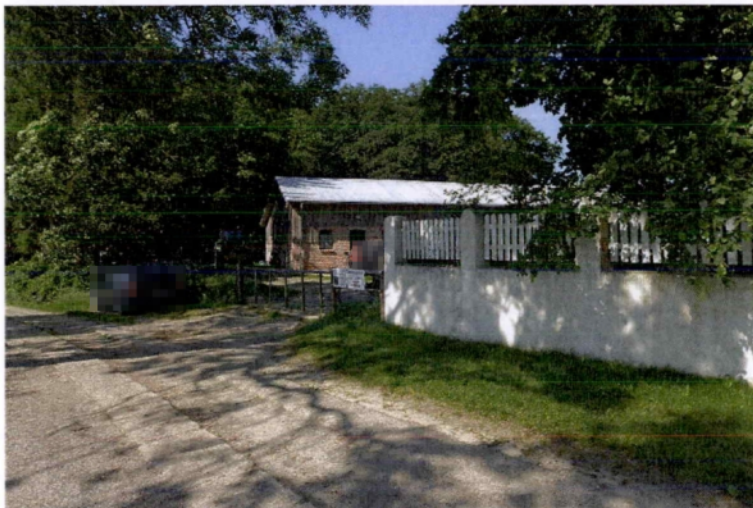
14. Straßenansicht mit Stallgebäude
