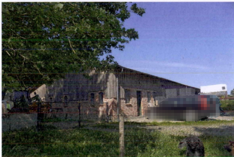
15. Flurstück 14/1 mit Teil-Stallgebäude
