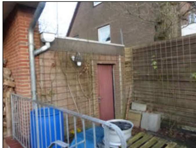
Garage von Südsüdwesten
