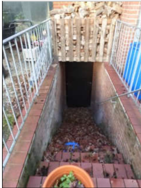
Blick auf die Kelleraußentreppe
