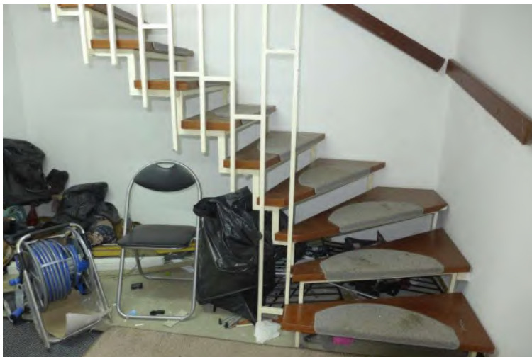
21. Treppe zum DG u. Keller
