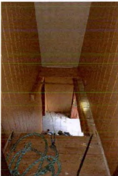
54. Entfernte Treppe DG
