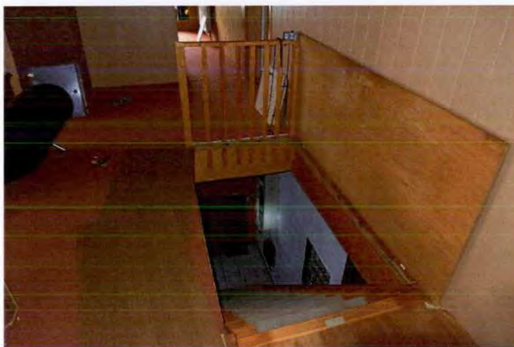
45. Flur DG - ohne Geländer
