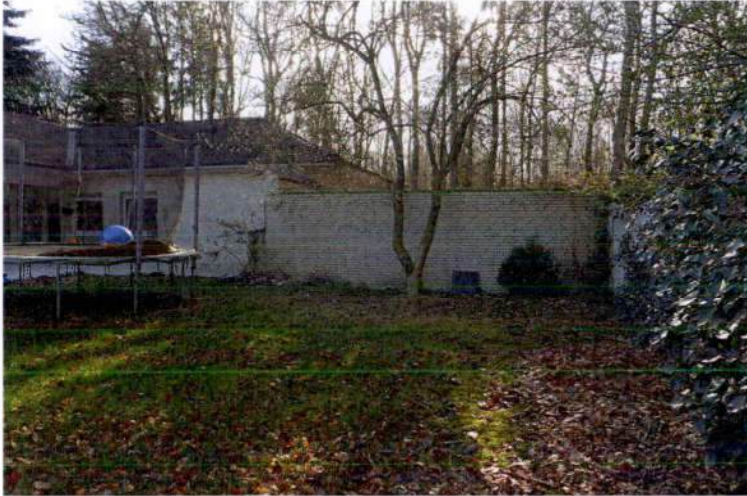
4. Westansicht m. Mauer zur Auffahrt
