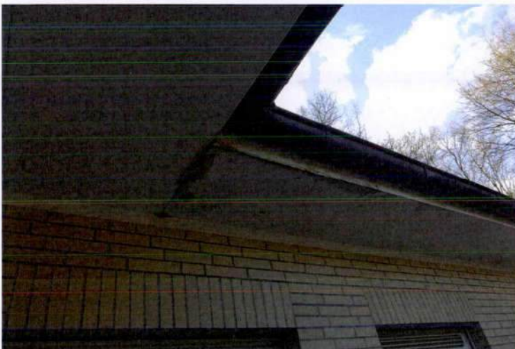
Feuchtigkeit unter Dachüberstand
