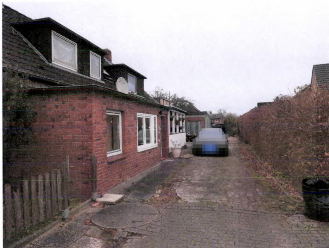
Auffahrt, von Südwesten aus gesehen
