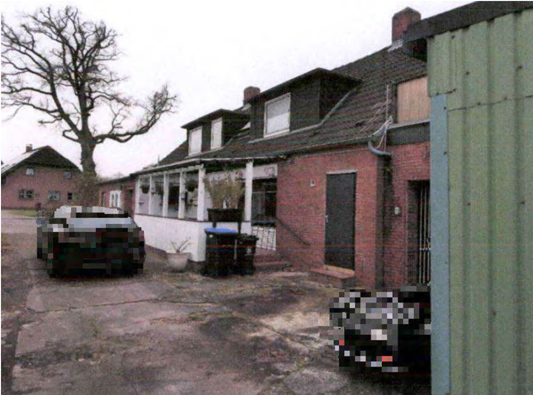
Auffahrt, hier in Richtung Straße gesehen
