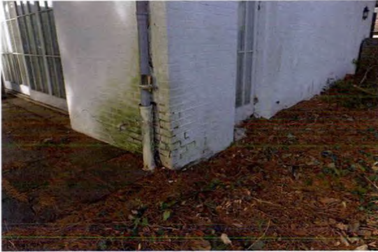
Hauseckbereich - Fassadenschaden
