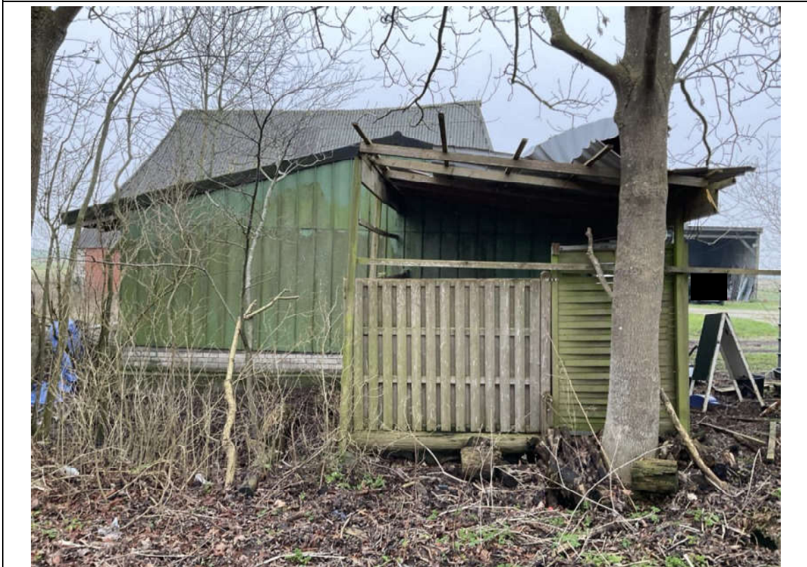
Bild 7: Carport: Blick von Südosten
