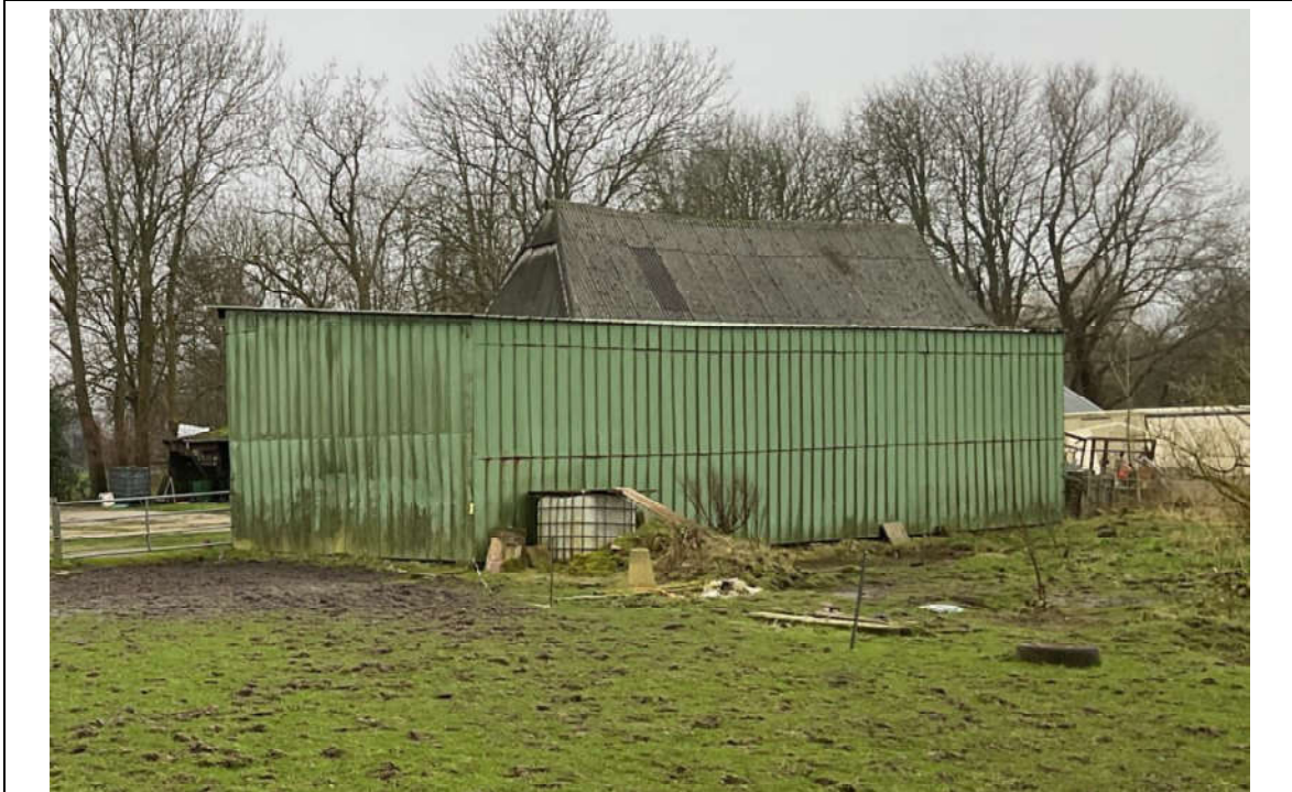
Bild 14: Pulldachhalle: Blick von Norden
