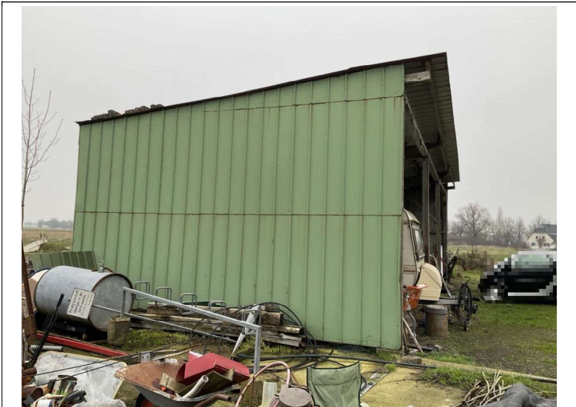
Bild 13: Pulldachhalle: Blick von Südosten
