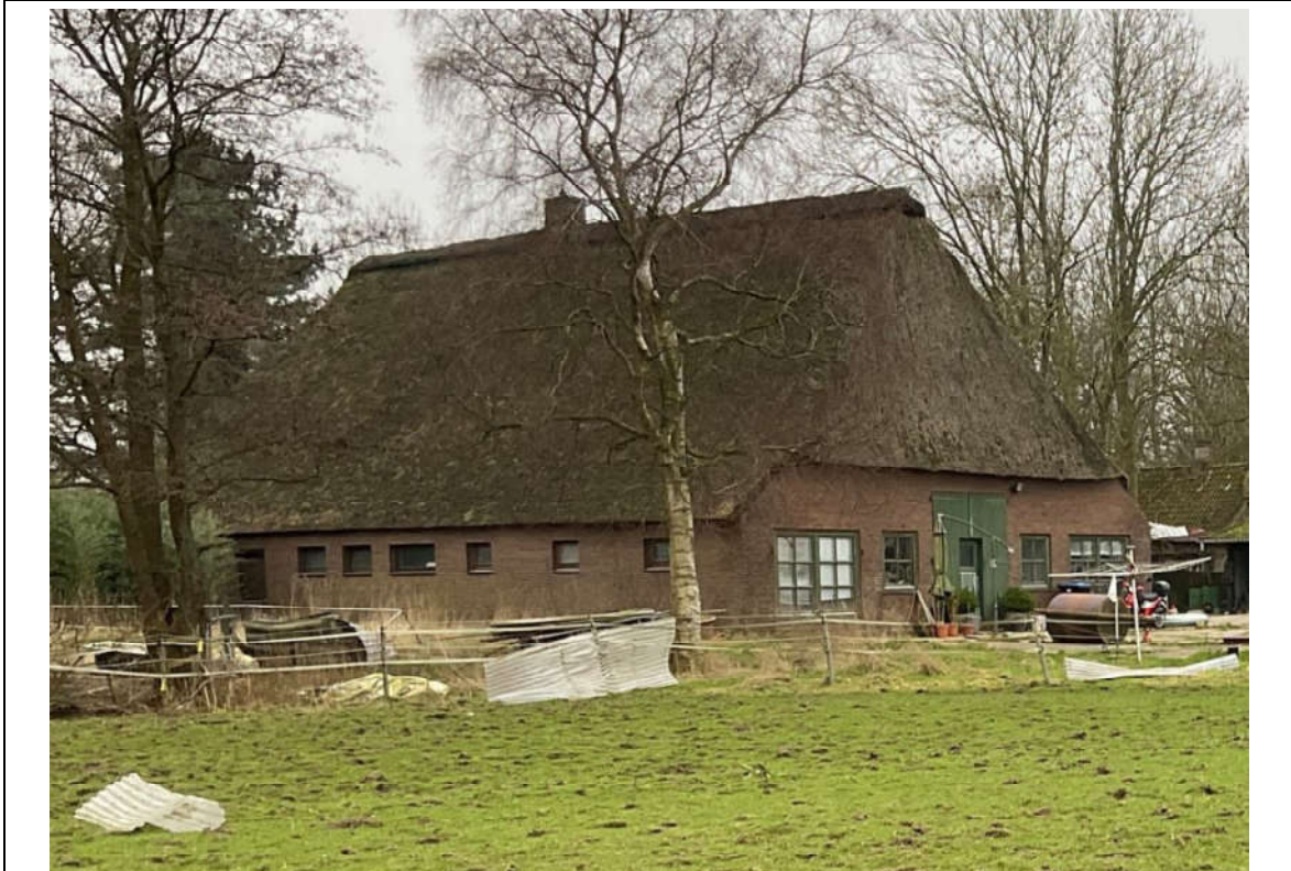
Bild 4: Wohnhaus: Blick von Norden
