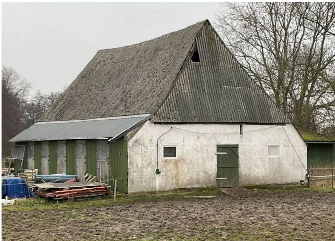
Bild 10: Pferdestall: Blick von Süden
