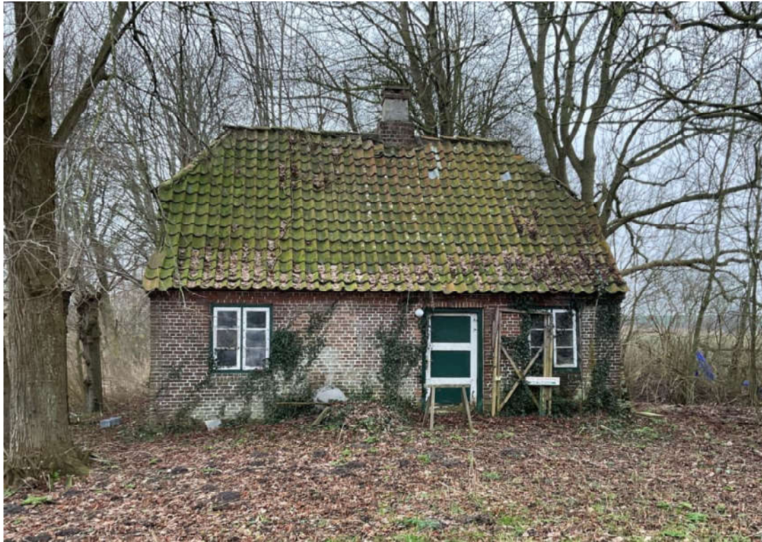
Bild 15: Nebenhaus: Blick von Nordosten
