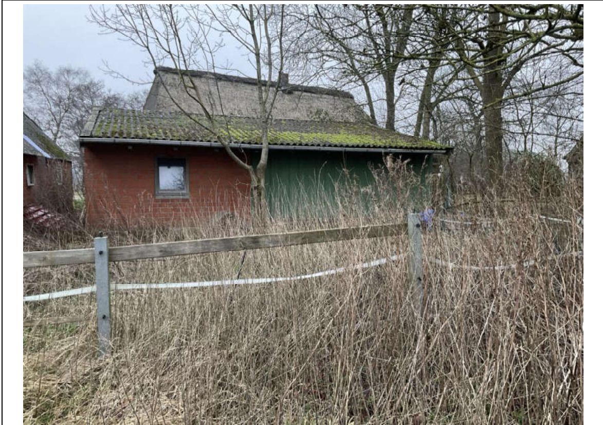
Bild 8: Carport: Blick von Südwesten
