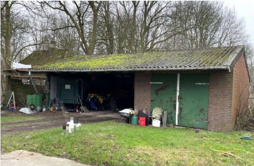
Bild 6: Carport: Blick von Norden
