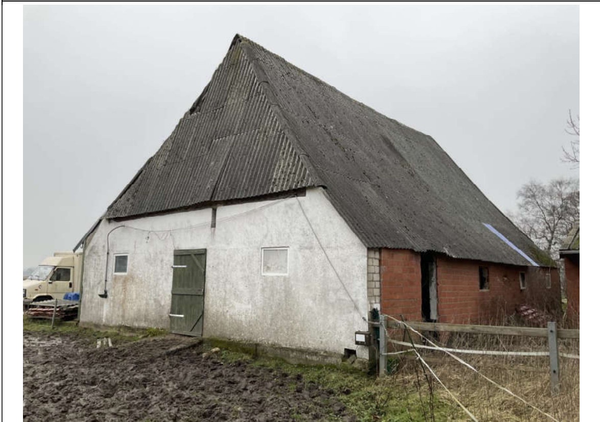
Bild 11: Pferdestall: Blick von Süden
