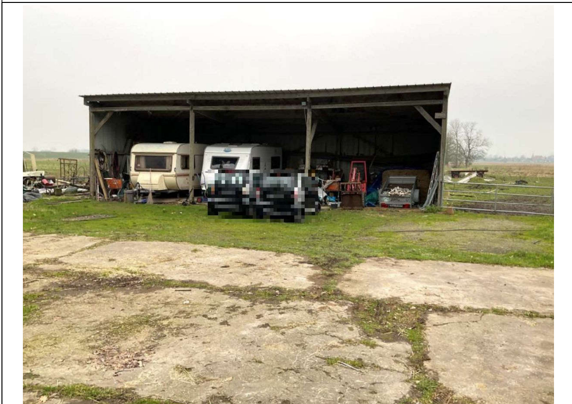
Bild 12: Pultdachhalle: Blick von Südosten
