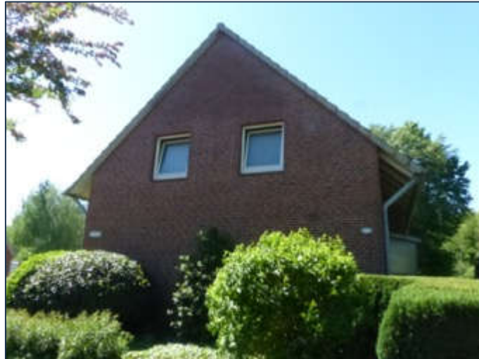
Straßenansicht von Nordnordosten
