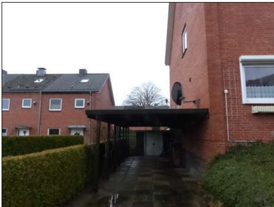
Blick auf das Carport
