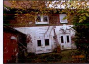
Nordansicht vom Innenhof
