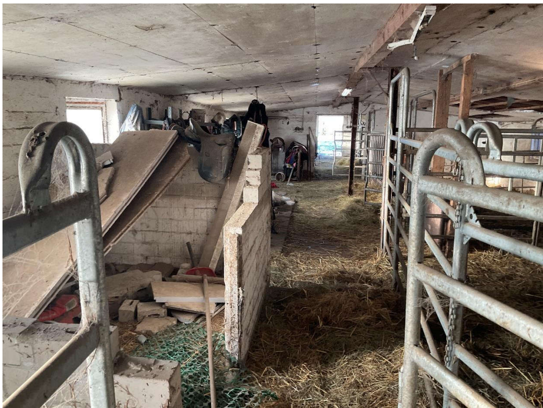
Bild 14: Pferde stall II: Blick in den südöstlichen Stallteil Richtung Nordwesten mit dem Durchgang zum nordwestlichen Stallteil
