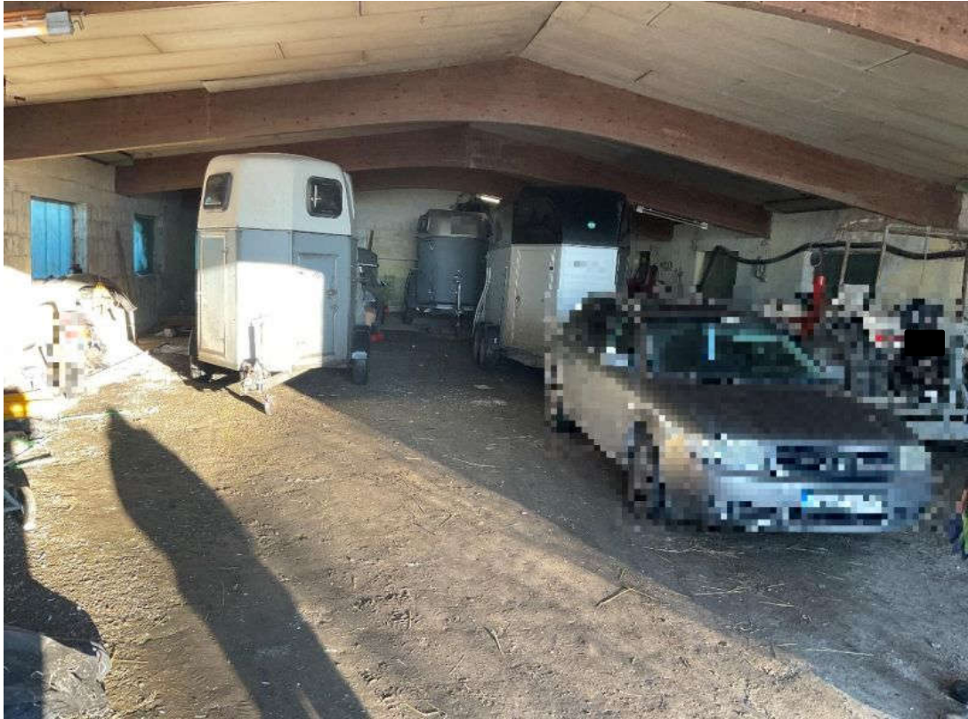
Bild 21: Halle II: Innenansicht von der südwestlichen Giebelseite aus
