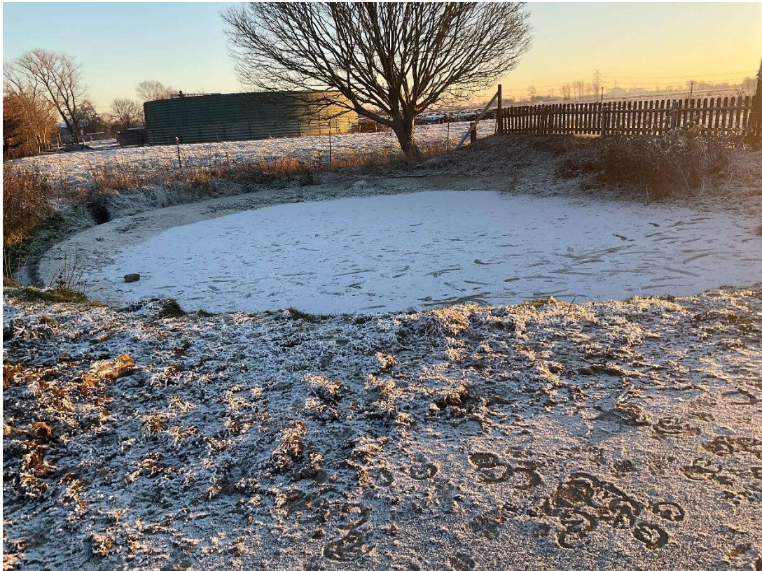
Bild 23: Bodenplatte des bereits abgerissenen Güllebehälters: Blick von Norden
