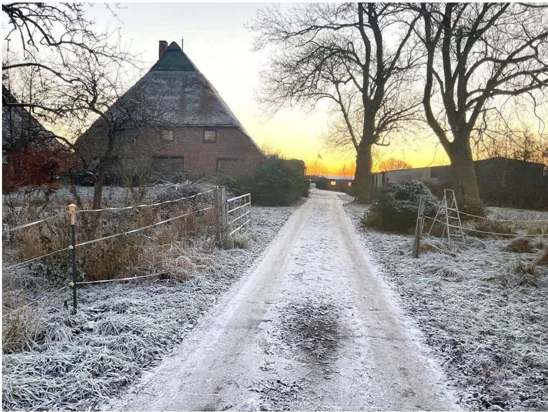
Bild 1: Blick von der Erschließungsstraße "Rotenmeer" auf die Zufahrt und den Wohnteil des Wohn- und Wirtschaftsgebäudes
