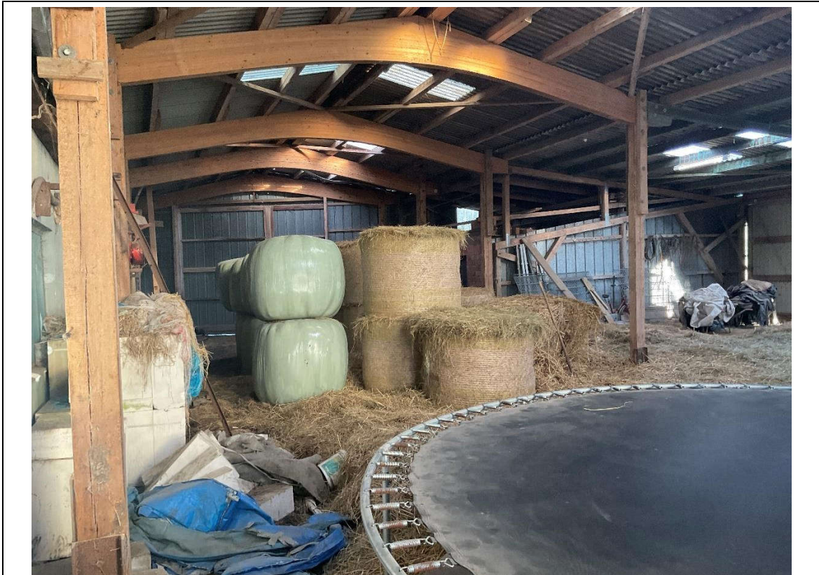
Bild 17: Halle I: Innenansicht von der westlichen Hallenecke aus
