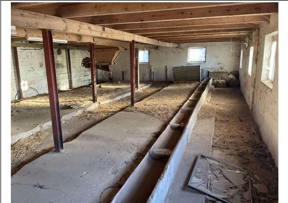
Bild 8: Stall I: Innenansicht von der nordwestlichen Stallecke aus
