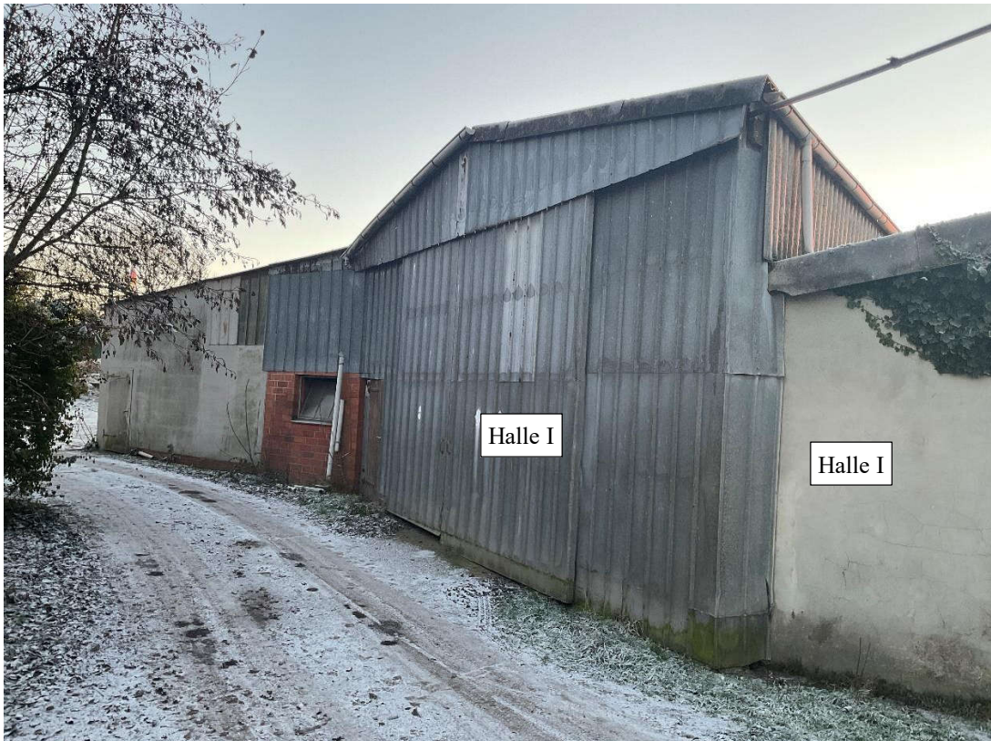
Bild 16: Halle I + II: Blick von Norden
