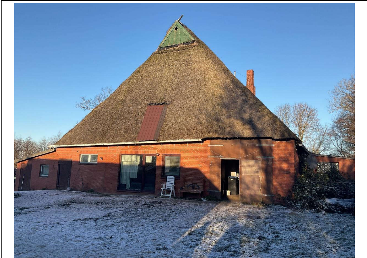
Bild 4: Wohn- und Wirtschaftsgebäude: Blick von Südwesten
