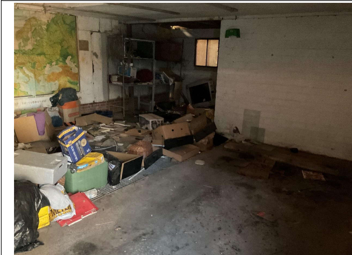
Bild 18: Halle I: Blick in die Garage in der östlichen Hallenecke.
