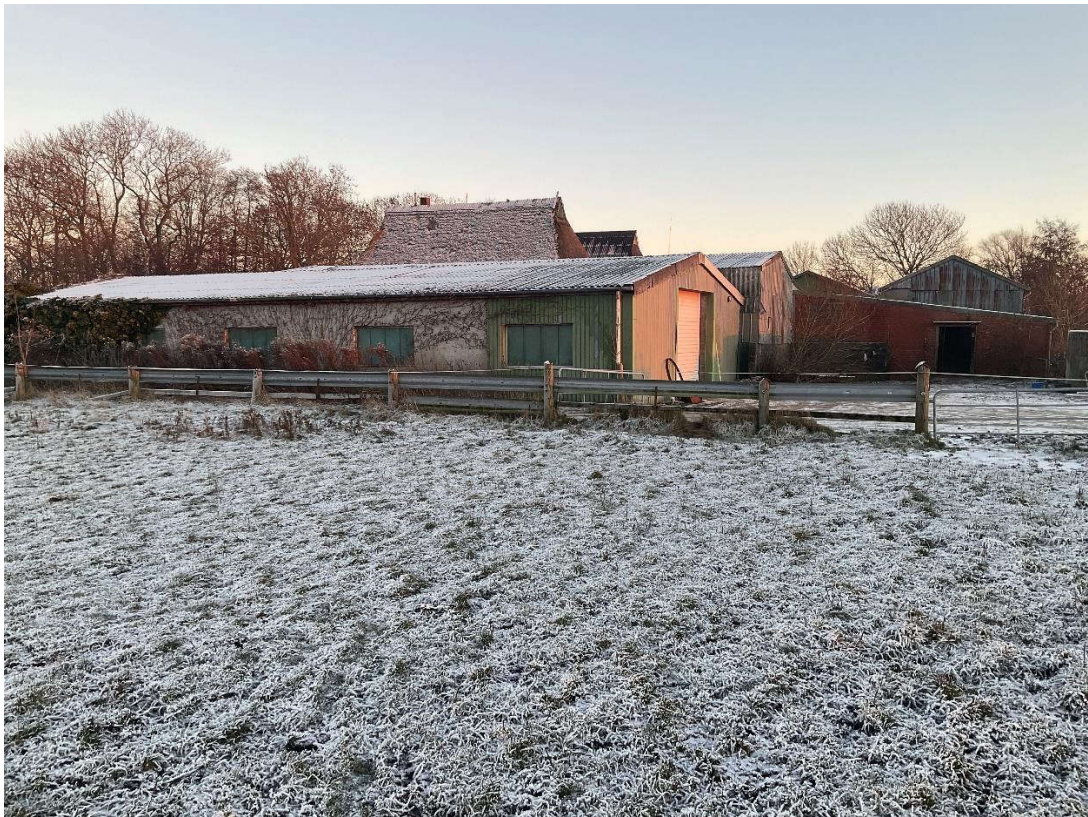
Bild 20: Halle II: Blick von Nordwesten
