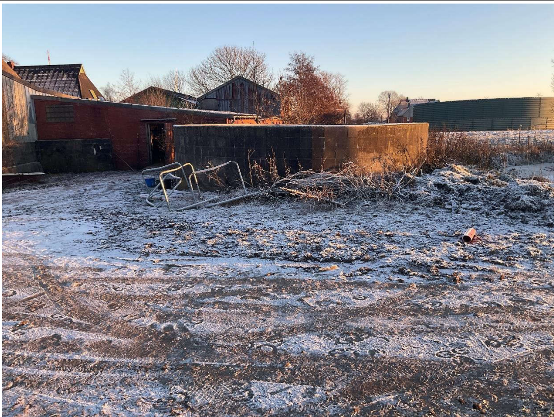
Bild 22: Güllebehälter: Blick von Nordwesten
