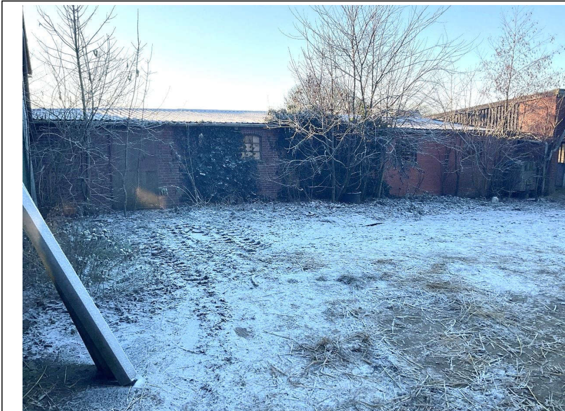
Bild 9: Pferdestall II: Blick von Osten auf den südöstlichen Teil.
