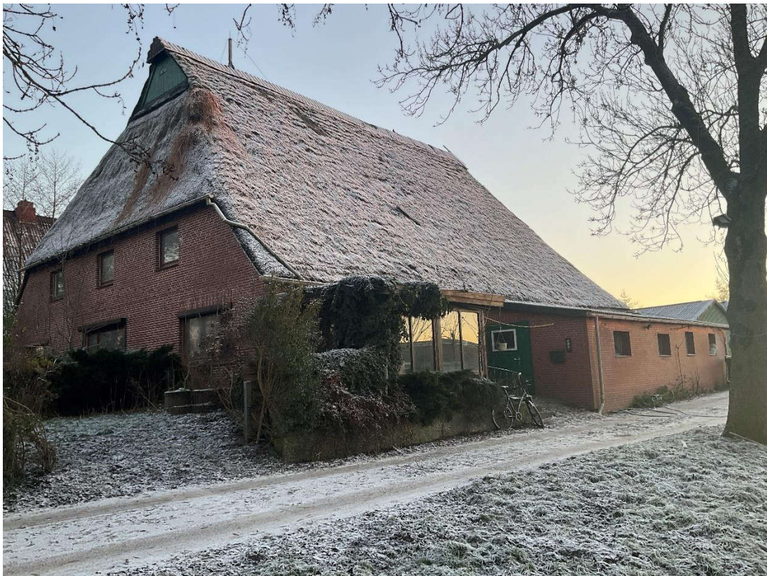
Bild 2: Wohn- und Wirtschaftsgebäude: Blick von Norden
