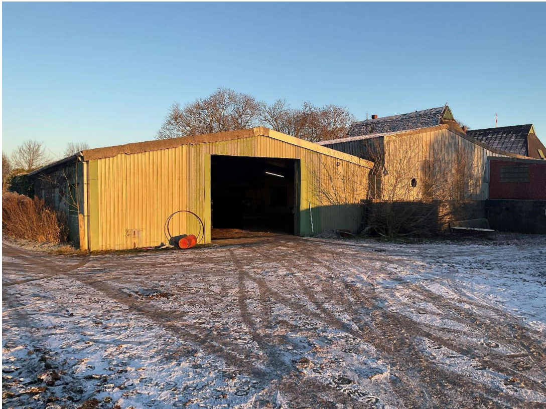
Bild 19: Halle II: Blick von Südwesten
