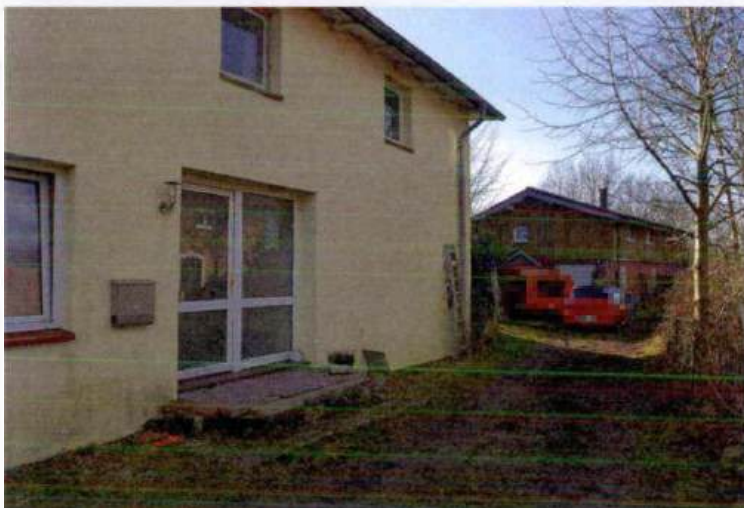
Hauseingang /hinten Nachbarhaus 7a
