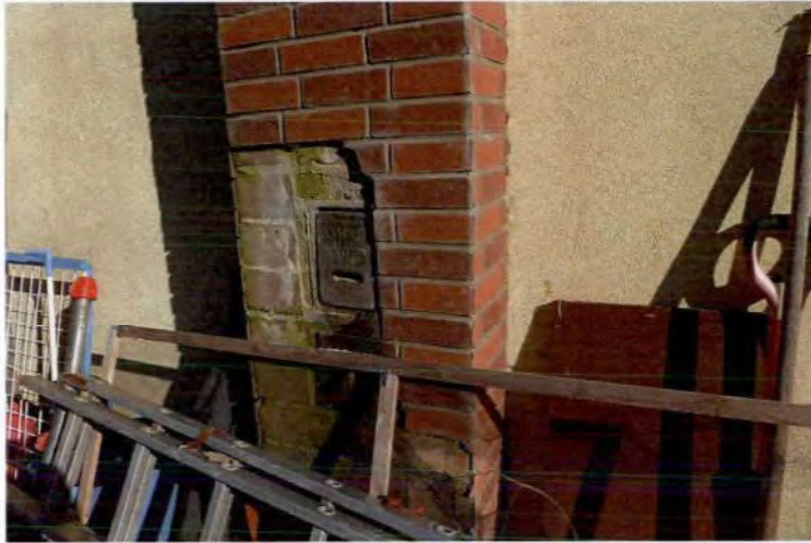
Fehlende/gebr. Flachverblender
