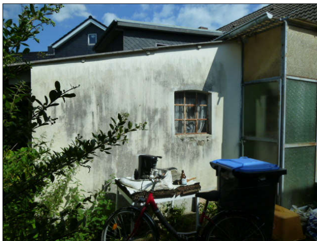
Bild 11 Nebengebäude, Ansicht von Süd-Westen
