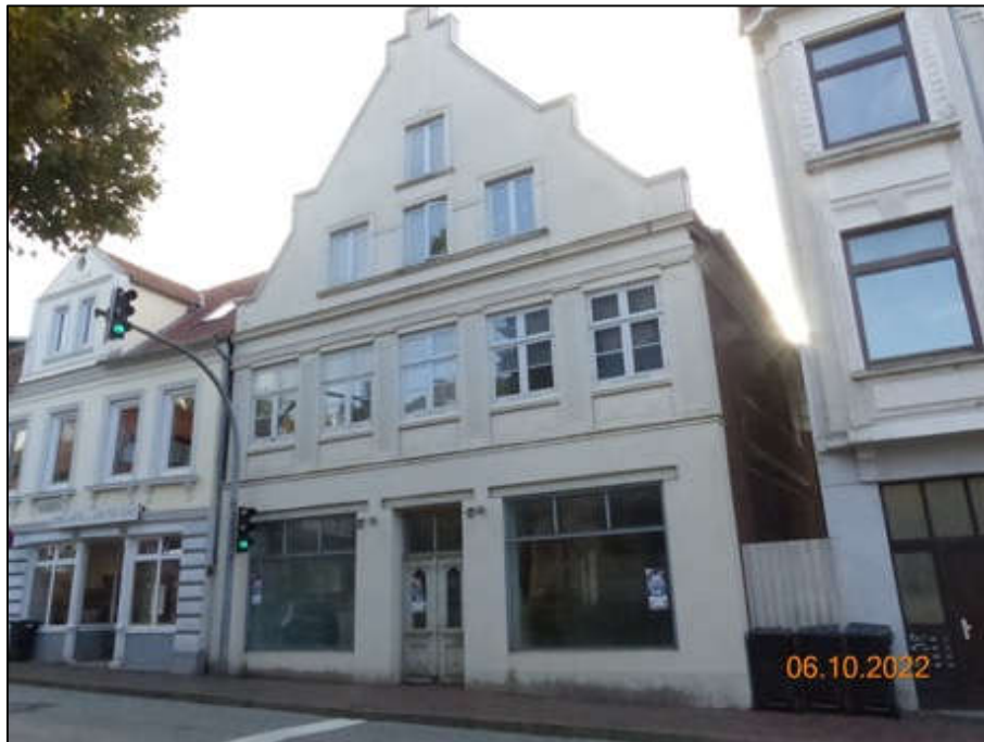
Ansicht von Nordwest
