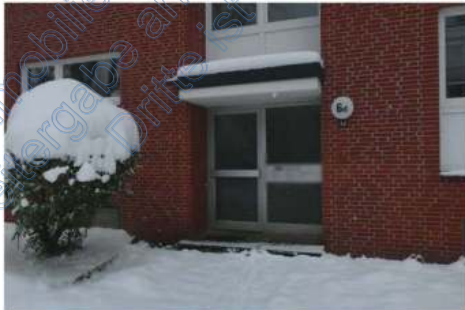
Eingangsansicht Tannenallee Nr. 6 d
