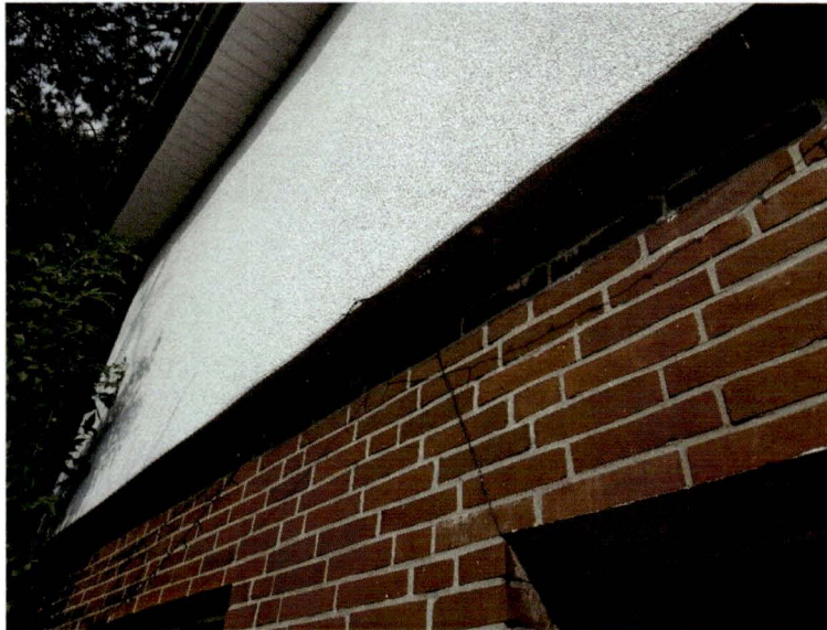
Bild 13: Fassade mit Dämmung
