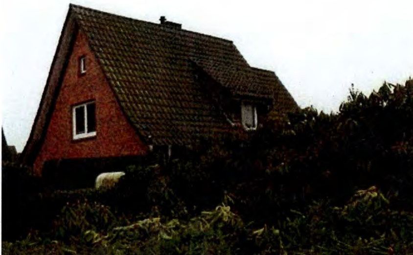
Bild 2: nordöstliche Ansicht / Dachfläche mit Gaube
