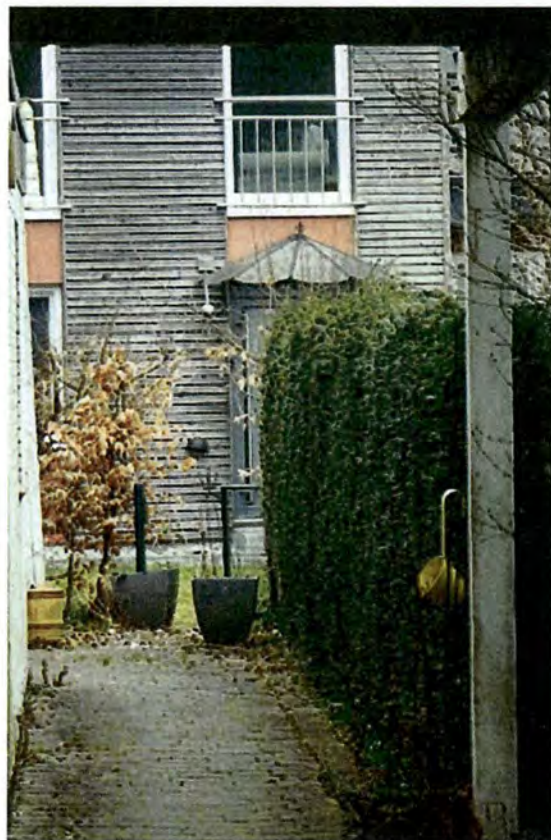
Bild 10: Südansicht mit separaten Eingang zu der Einliegerwohnung
