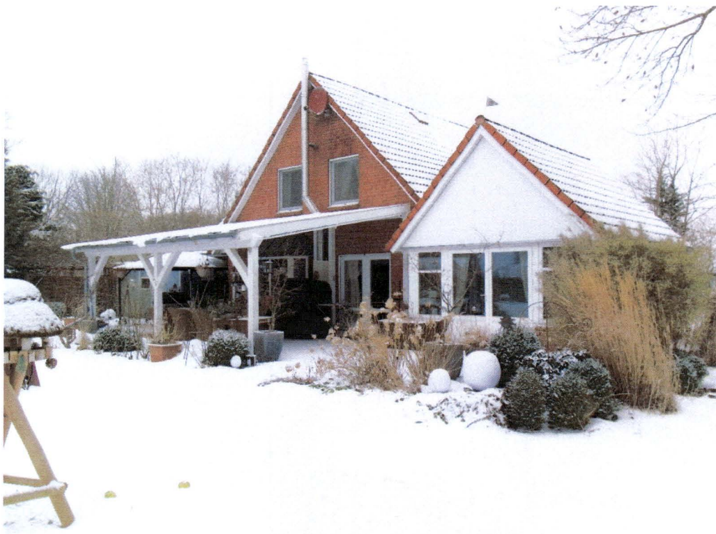
Ansicht von Süd-Osten
