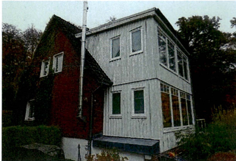
Bild 9: Südwestansicht mit Wintergartenanbau
