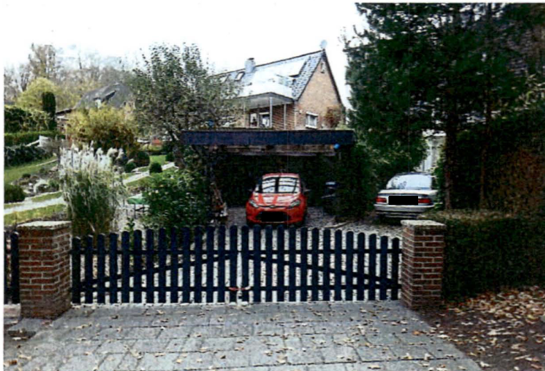
Bild 10: Zufahrt zum Kfz-Stellplatz über das Nachbargrundstück
