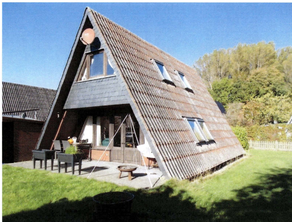
Ansicht von Süd-Osten
