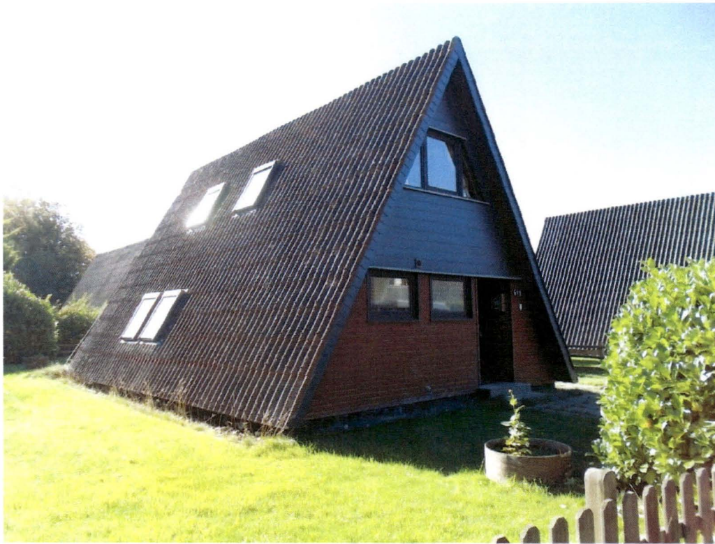
Straßenansicht von Nord-Osten
