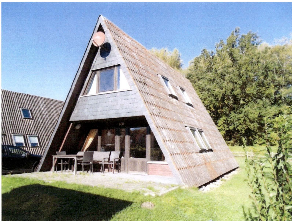
Ansicht von Süd-Osten
