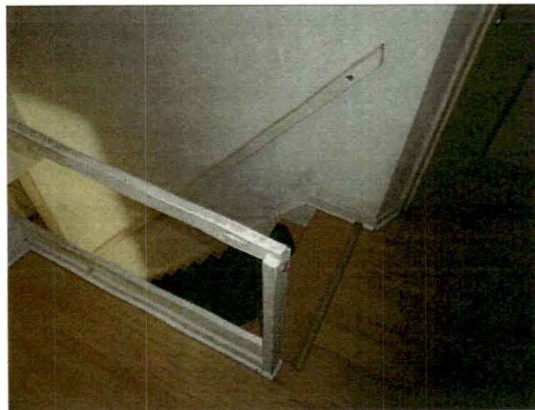
Bild 26: Flur und Treppe im Dachgeschoss
